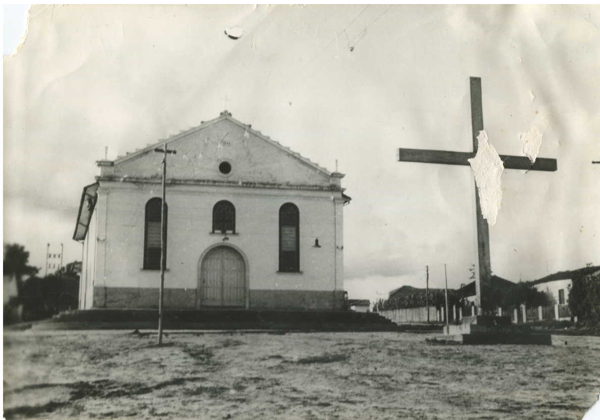
Vista da fachada e Largo da Capela de São Benedito.
